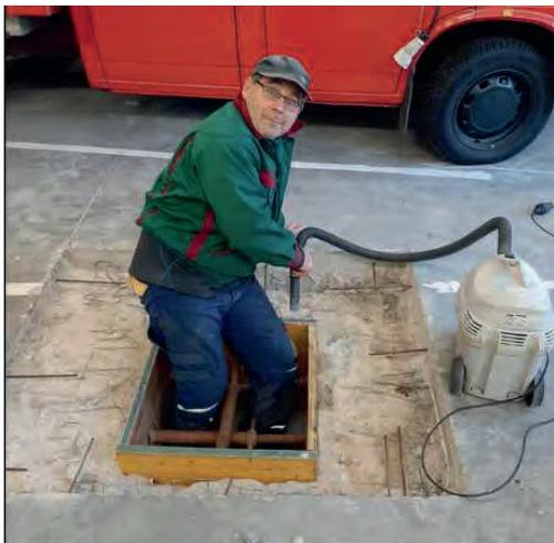
Ferner wies der Rahmen der Garagenschachtwanne unter unserem Rüst-Löschfahrzeug intensive Korrosionsspuren auf und drohte beim Überfahren nachzugeben. Mit der Unterstützung einiger Kameraden wurde der alte Rahmen samt Oberteil der Wanne heraus gestemmt, die Wanne mit einem neuen Rahmen bestückt und frisch einbetoniert. Zum Schluss wird der neu betonierte Bereich noch grundiert und versiegelt um den Boden Öl- und salzbeständig zu machen.
